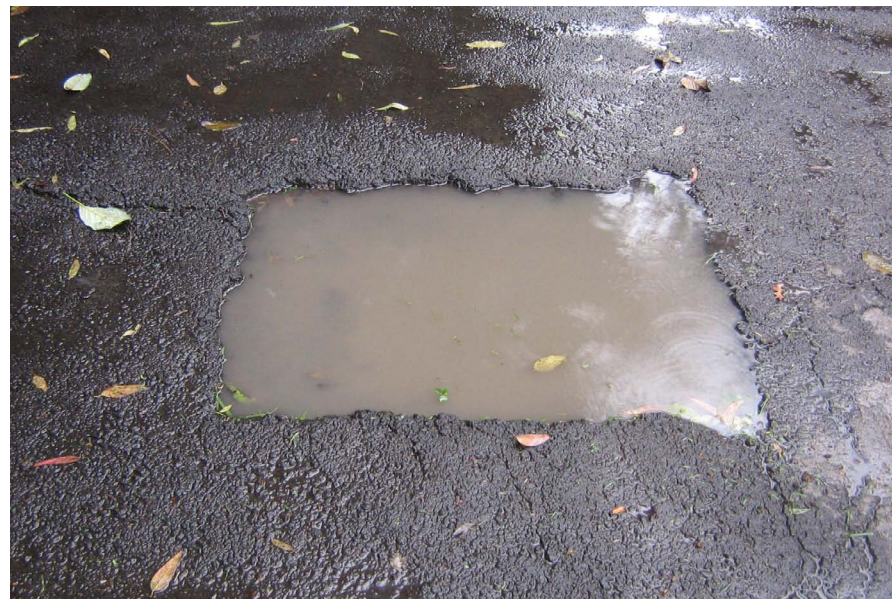
Viernes 06 de septiembre 2013 Concreto, cuadrado, agua de lluvia. Postal para Oscar Berglund
